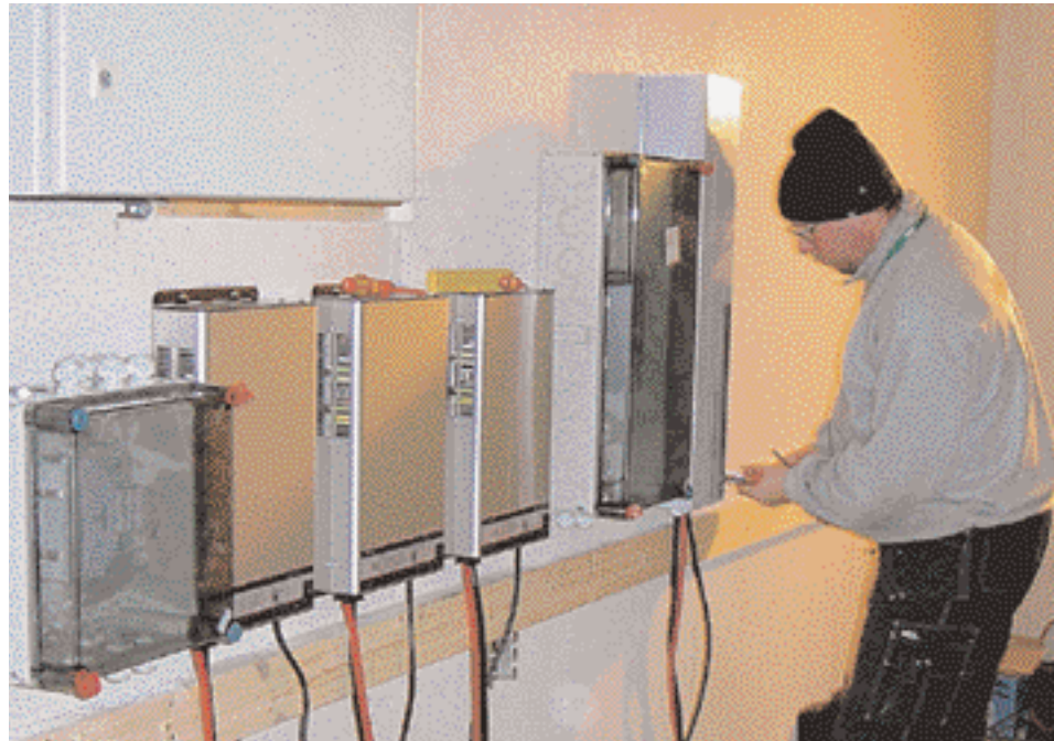
Mats Rönning installerar omformare som omvandlar 48 V DC till 3-fas växelström i Snadnaset.
